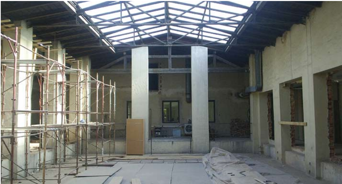
Renoviran je svjetlarnik iznad glavnog hola
