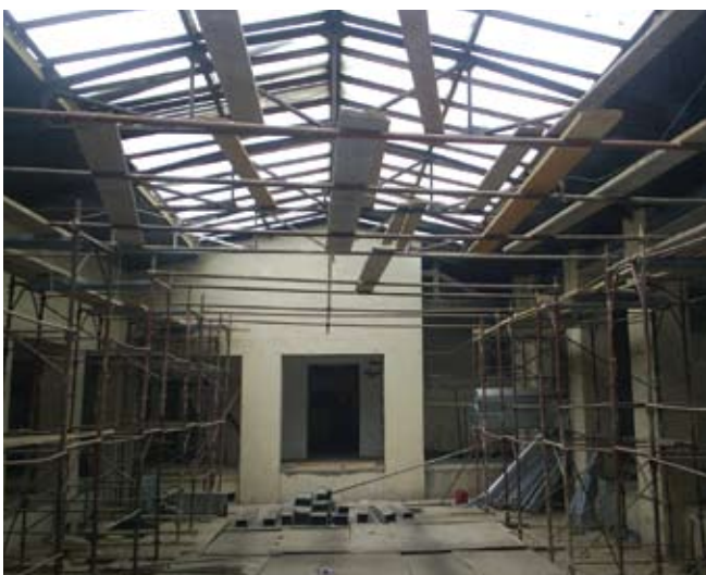
Renoviran je svjetlarnik iznad glavnog hola
