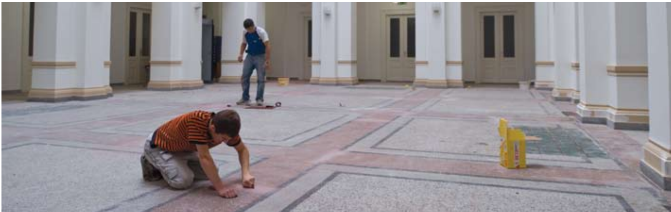
Pod glavnog hola je pažljivo ispoliran i tretiran
