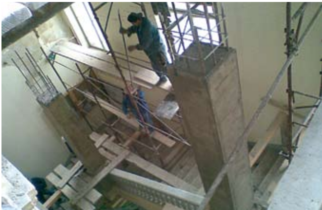
Bilo je potrebno izgraditi nove stepenice koje vode do potkrovlja
