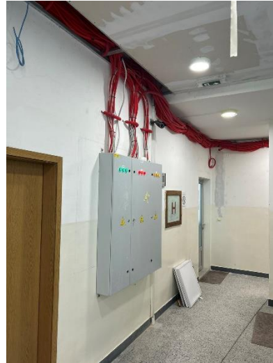
Slike 23 i 24: Rekonstrukcija elektroenergetske mreže u zgradi Općinskog suda u Kaknju
