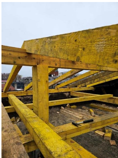
Slike 26 i 27: Sanacija krovne konstrukcije dijela zgrade Palače pravde, oštećene u požaru 2023. godine
