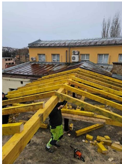
Slike 26 i 27: Sanacija krovne konstrukcije dijela zgrade Palače pravde, oštećene u požaru 2023. godine
